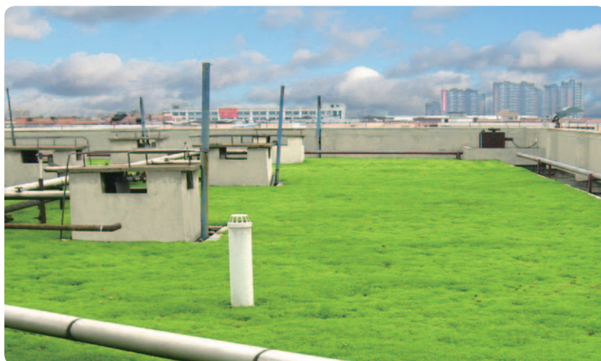
電子學習產品生產廠房的「綠色屋頂」
